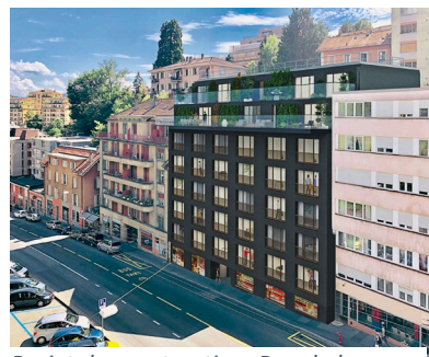
Projet de construction: Rue de la Borde, Lausanne
